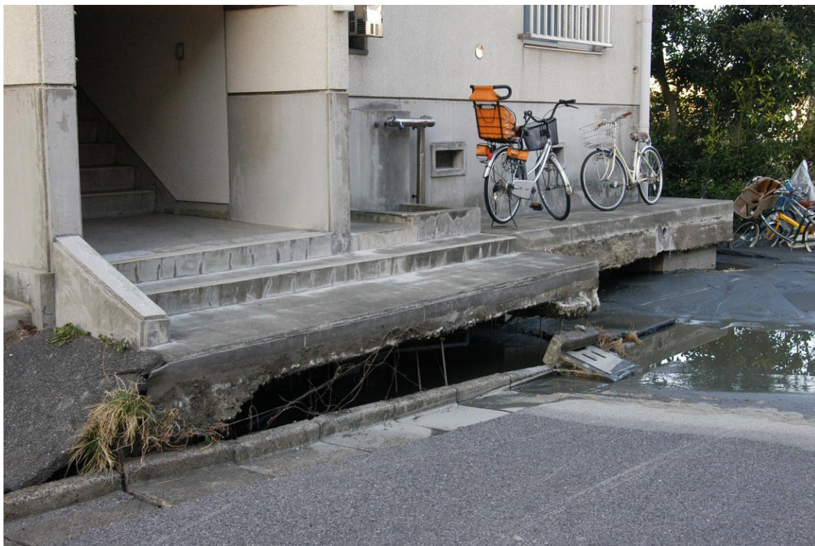
液状化現象による地盤沈下でできた段差（千葉県浦安市高洲）
